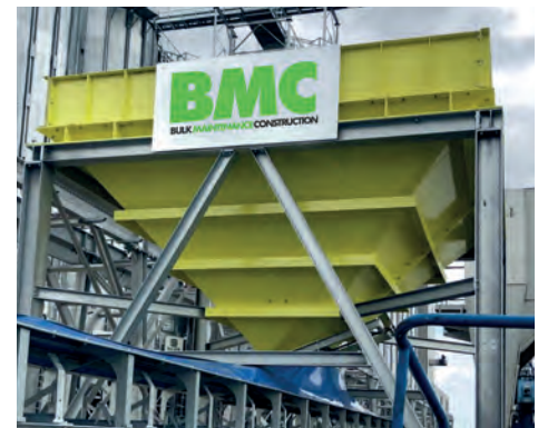
Afb. 4 De stortbunker mondt uit in de kadeband
